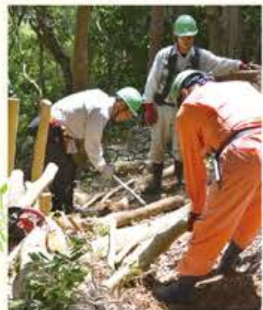
間伐をしながら、伐った木で無駄なく遊歩道をつくるのは土木の域。「地味にきつい作業やき」と苦笑いも
